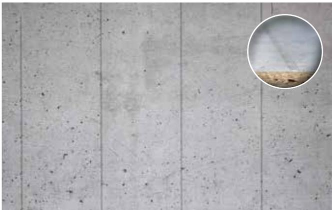
Beton Design - Schalungsfuge alle 100 mm
