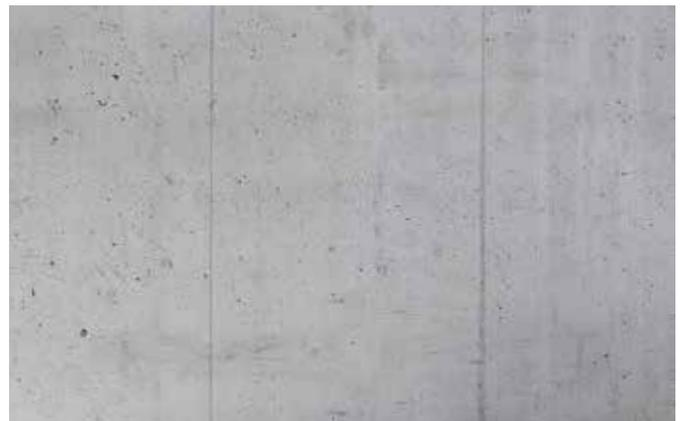
Beton Design - Schalungsfuge alle 400 mm
